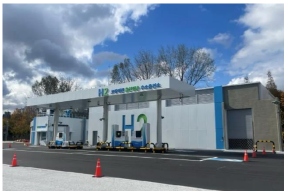
Trung tâm cung cấp hydro lớn nhất Hàn Quốc vào hoạt động. Ảnh: Ulsan City
